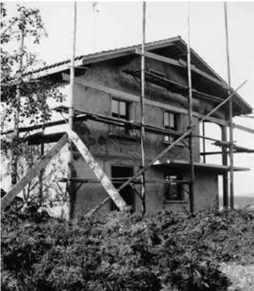
Construction de la première maison familiale des Pasquier
