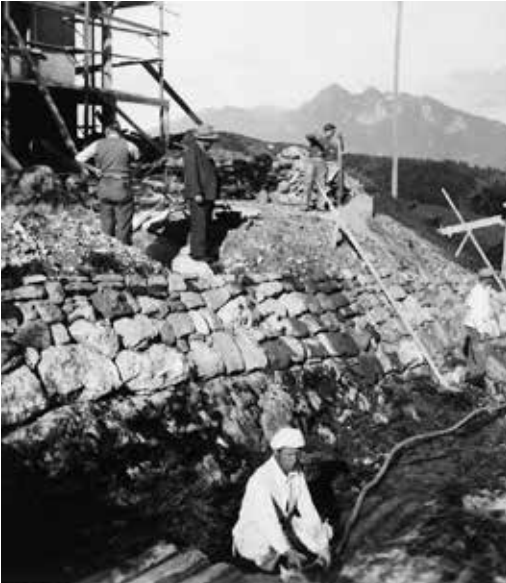
Chantier de la première maison familiale
