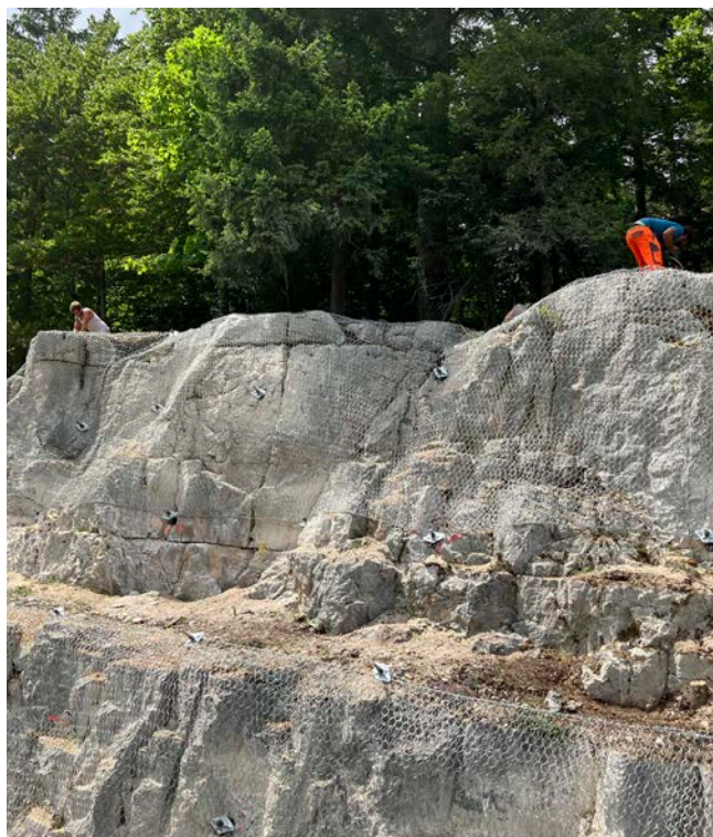
Sécurisation du rocher
