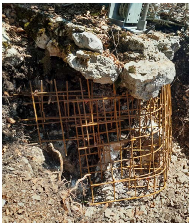
Réfection des socles existants de pare-pierres
