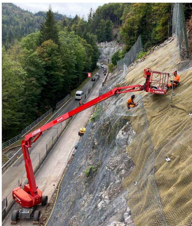
Mise en place natte contre érosion
