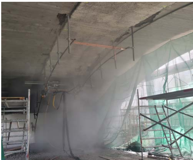
Travaux d'hydrodémolition des voûtes
