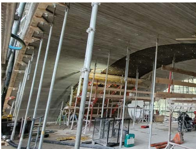
Coffrage des voûtes
