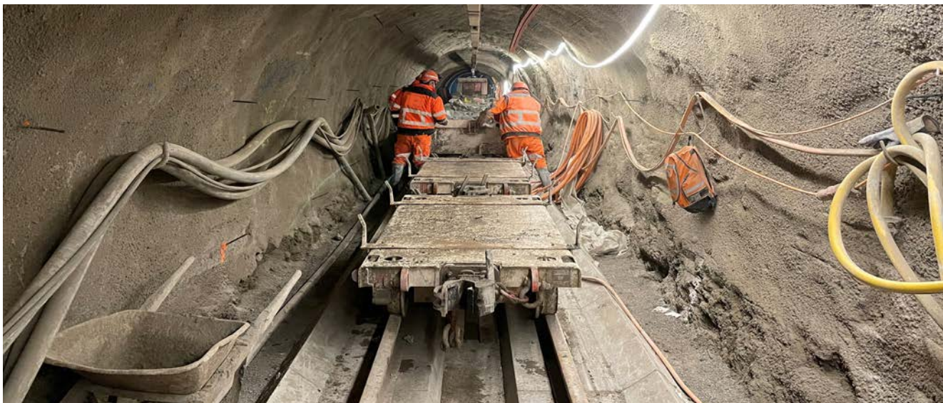
Transport des déblais vers l'extérieur
