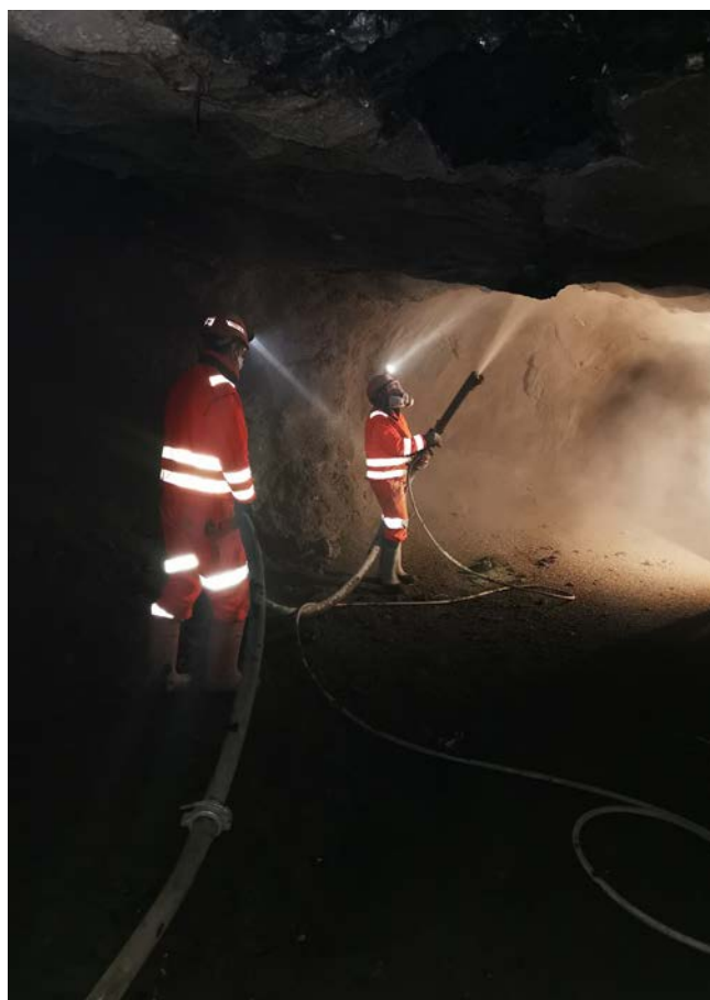
Béton projeté de sécurisation
