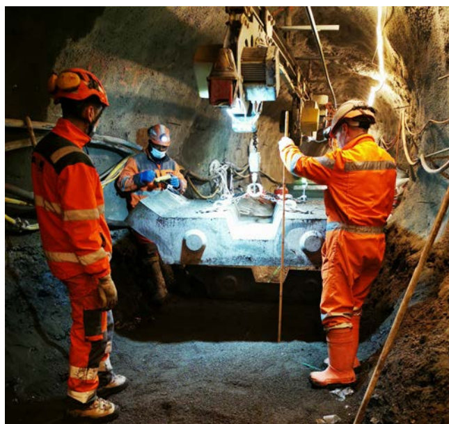
Pose des éléments préfabriqués du radier
