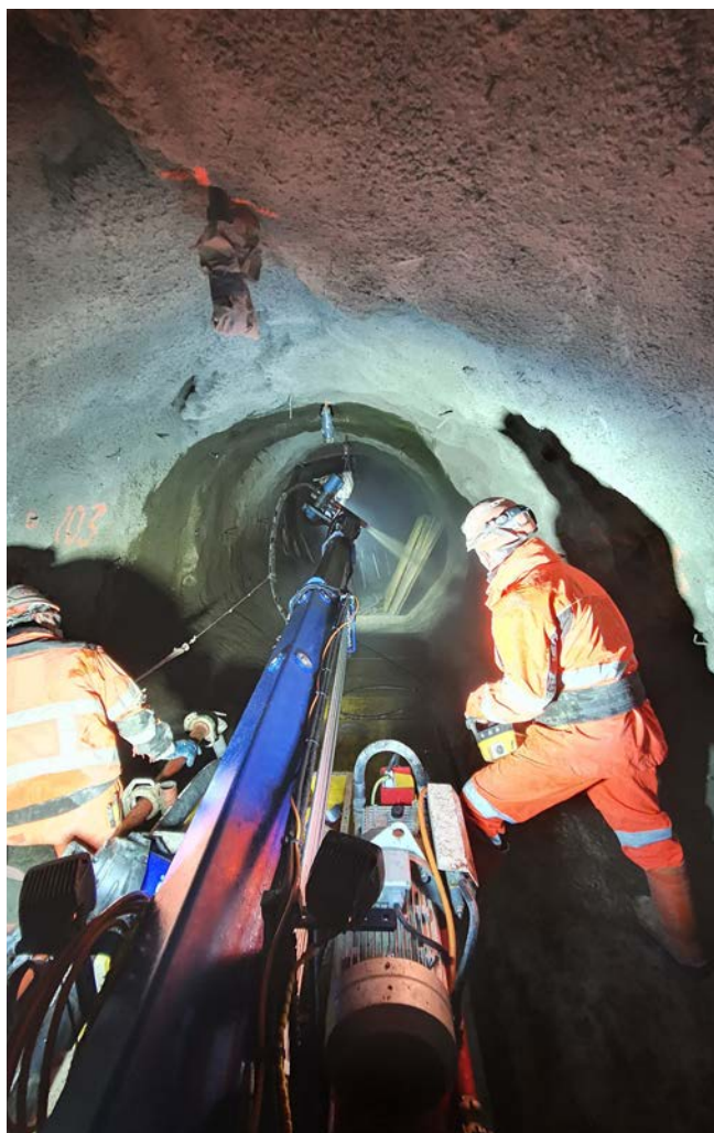
Revêtement périphérique avec du béton projeté fibré métallique
