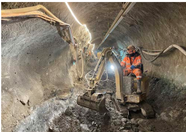
Marinage des déblais vers l'extérieur
