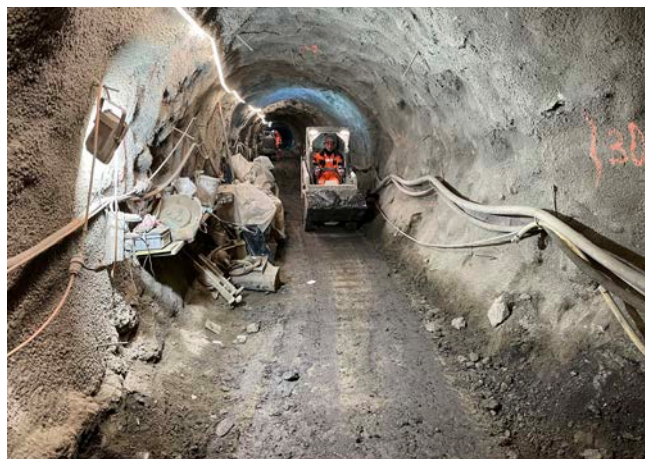
Marinage des déblais vers l'extérieur
