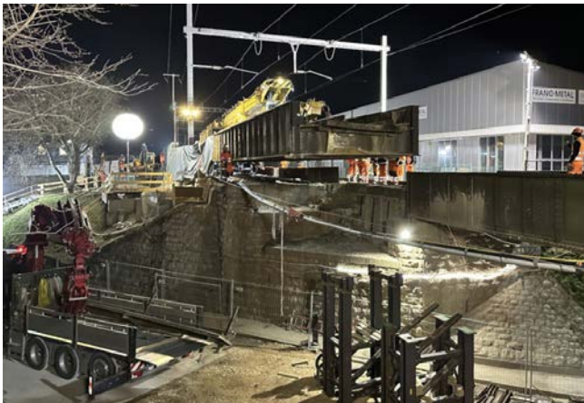
Source photo : Perret-Gentil SA > Dépose pont métallique 47 to
