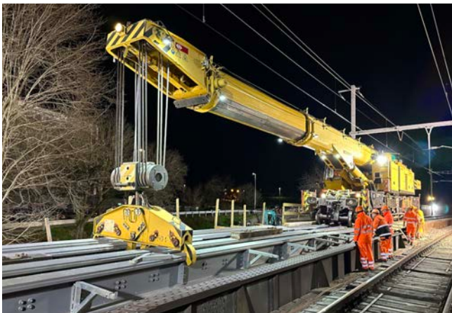
Source photo : Perret-Gentil SA > Pose des ponts provisoire
