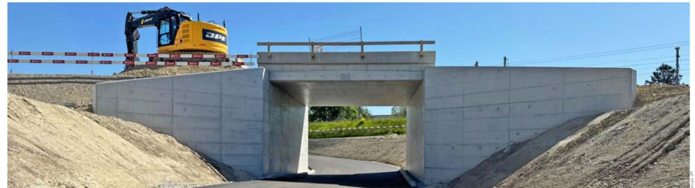
CONSTRUIT EN DEHORS DE LA NAPPE PHRÉATIQUE, LE PASSAGE INFÉRIEUR EN BÉTON ARMÉ, ROUTE D'EN FOREZ À CHAVORNAY, PERMET LE FRANCHISSEMENT SOUS VOIES
