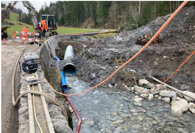
▲ Déviation provisoire ruisseau (secteur Torneresse) ▲
