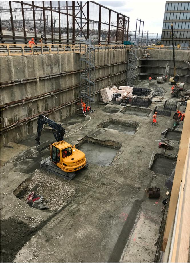
Exécution des surprofondeurs au niveau du radier
