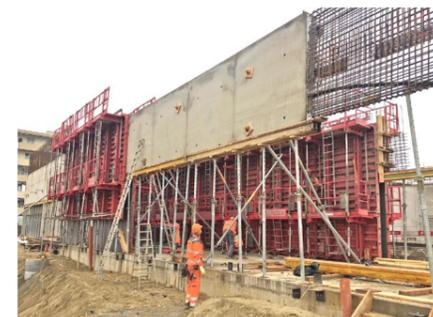
D'autres particularités du chantier ont résidé dans l'édification de murs à épaisseurs variables pour les studios conservatoires ou la fabrication de dalles nervurées, sans oublier l'extrême densité d'armatures dans toutes les portions d'ouvrages réalisées.
