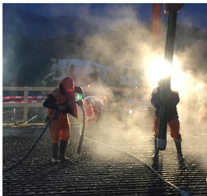
Bétonnage du tablier du pont
