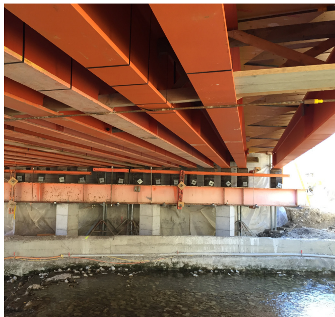
Etayage provisoire du tablier
