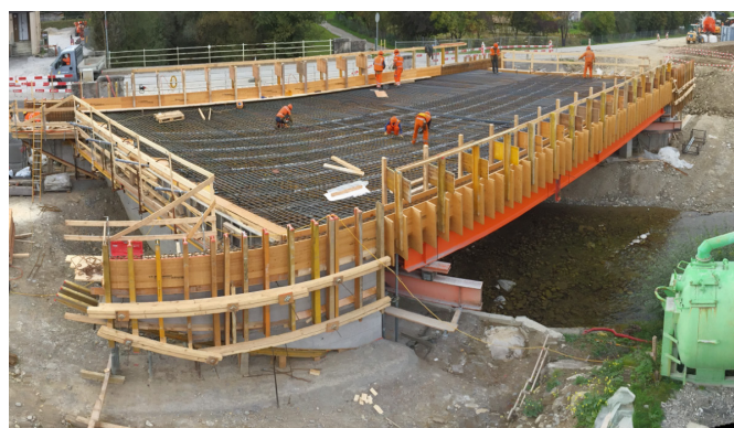
Mise en place de l'armature du tablier
