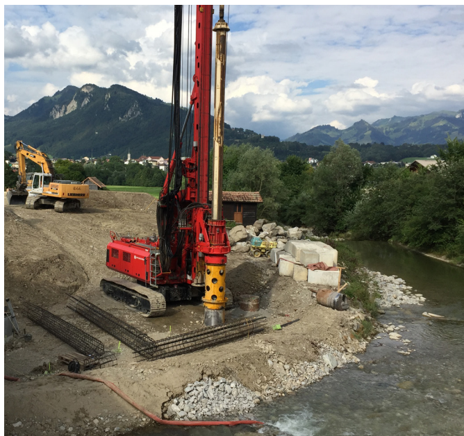
Exécution des pieux pour fondation des culées
