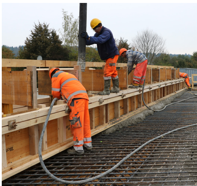
Bétonnage du bord du tablier
