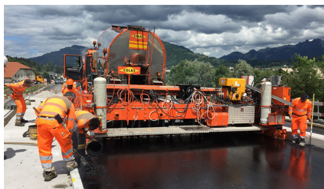
Mise en place de la couche de protection en asphalté coulé
