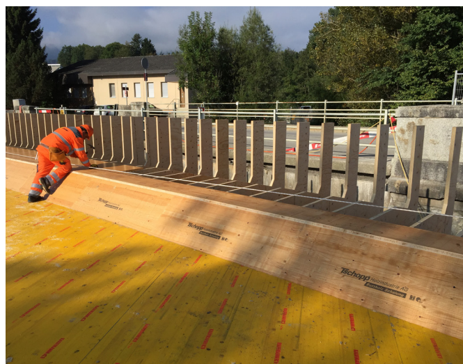
Coffrage du bord du tablier
