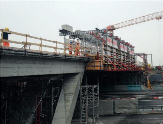
Chariot pour l'exécution du coffrage de la bordure en béton
