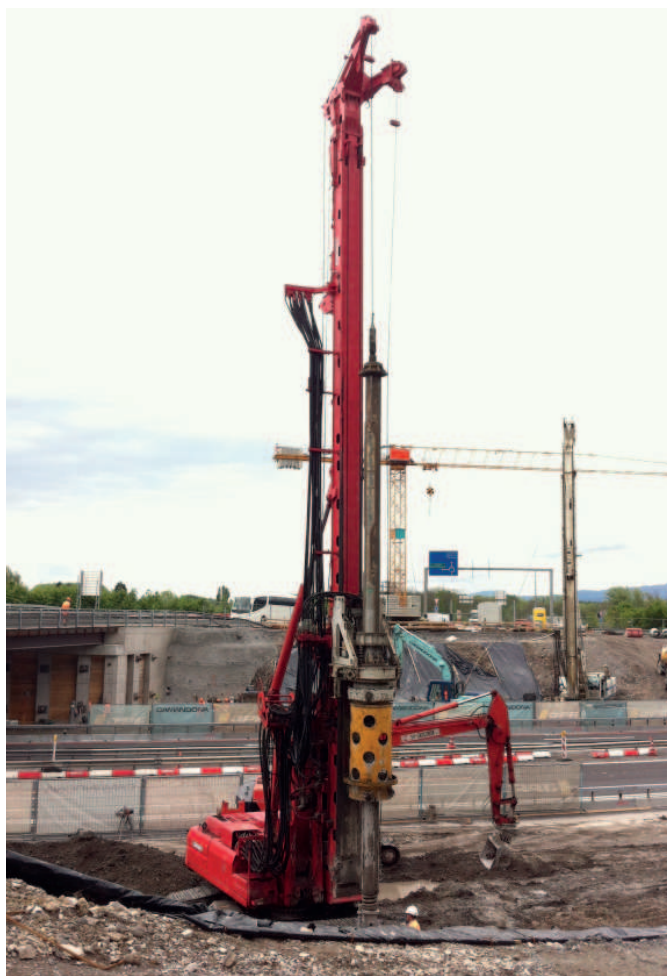
Forage pour l'exécution de la paroi de pieux sécants
