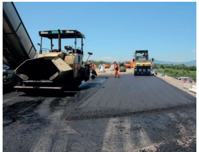
Mise en place de l'enrobé bitumineux
