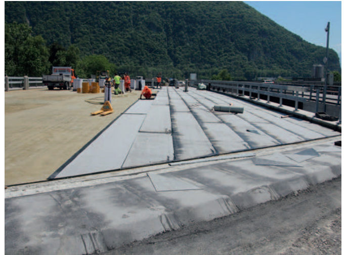
Exécution de l'étanchéité en lés de bitume polymère sur la résine époxy
