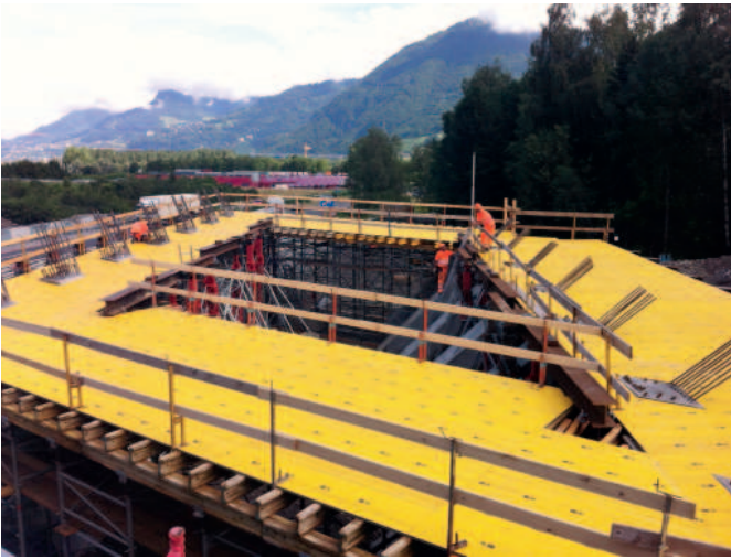
Coffrage des entretoises
