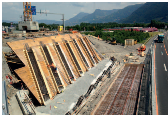
Exécution du coffrage des béquilles et mise en place des armatures
