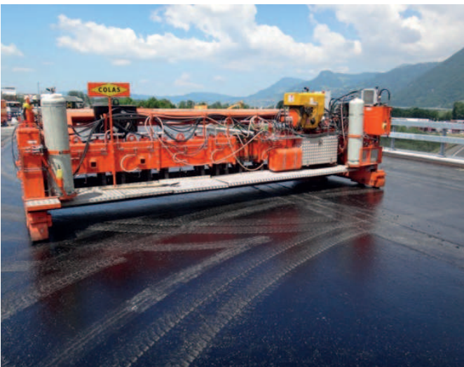
Mise en place de la couche de protection en asphalte coulé
