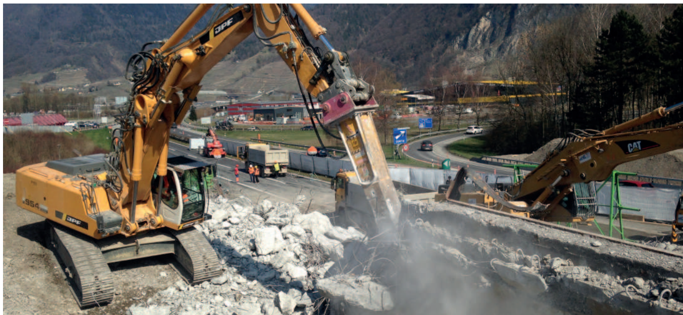
Démolition des murs de culée
