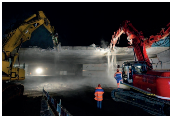
Démolition de la première partie du pont à la pince
