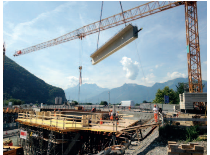
Mise en place des poutres préfabriquées des travées de rive
