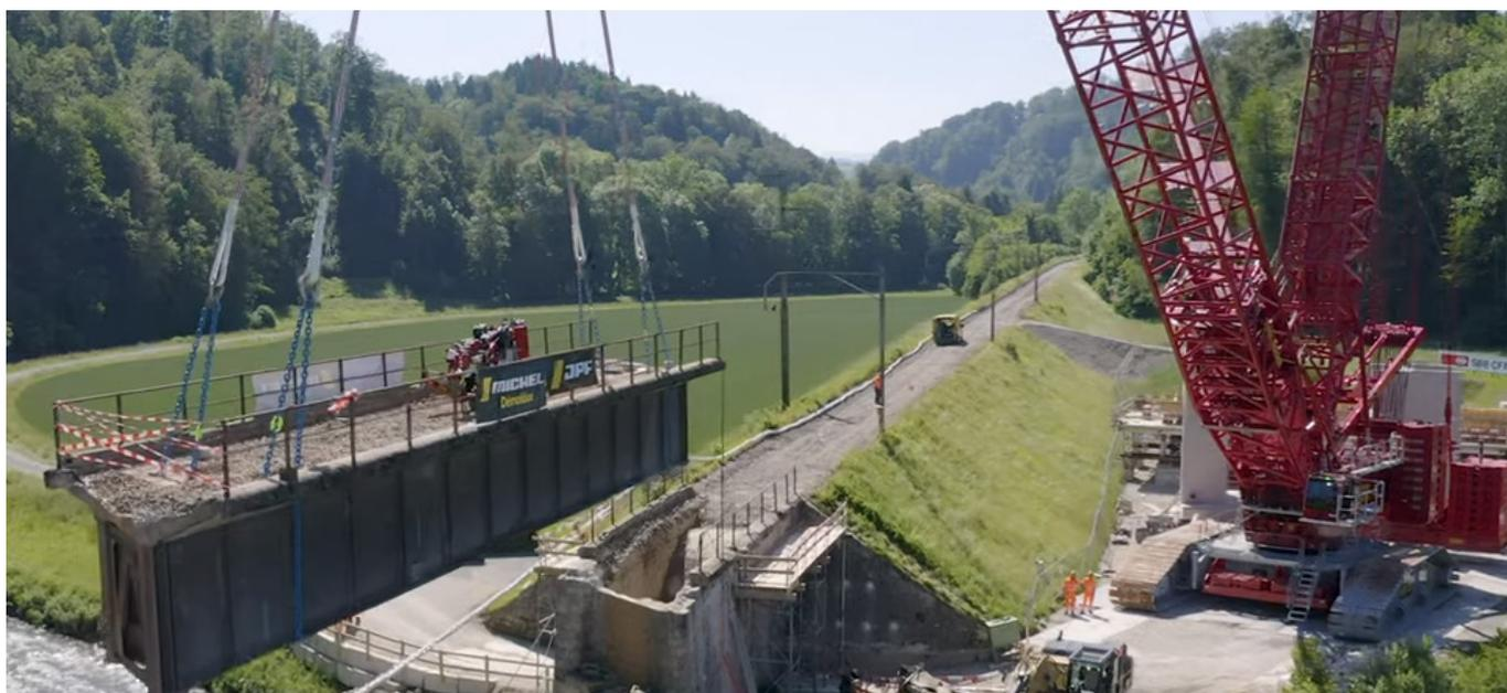
Démolition et dépose du tablier existant
