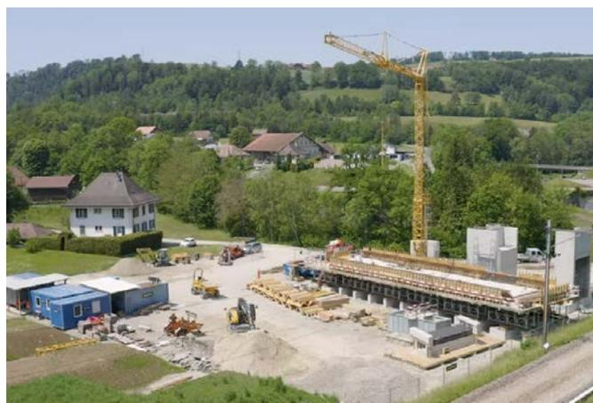
Préfabrication du tablier sur la place des installations de chantier
