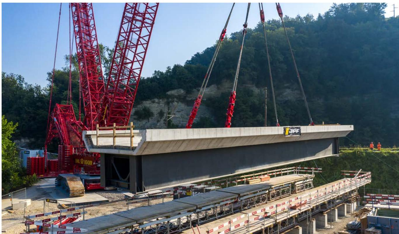
Élévation pour pose du tablier mixte acier-béton préfabriqué sur la place des installations de chantier
