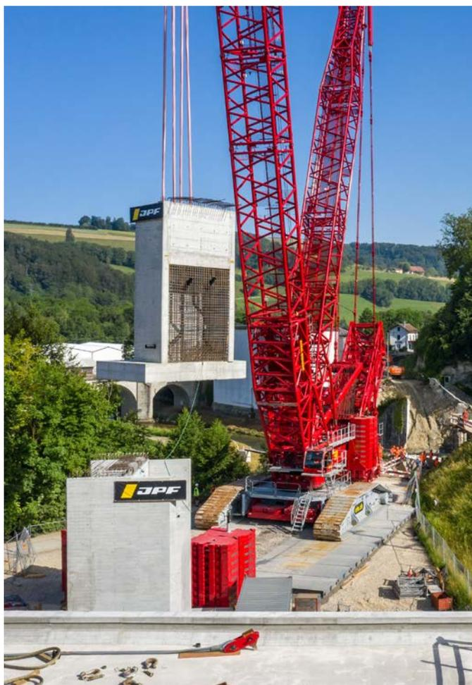
Élévation pour pose des culées
