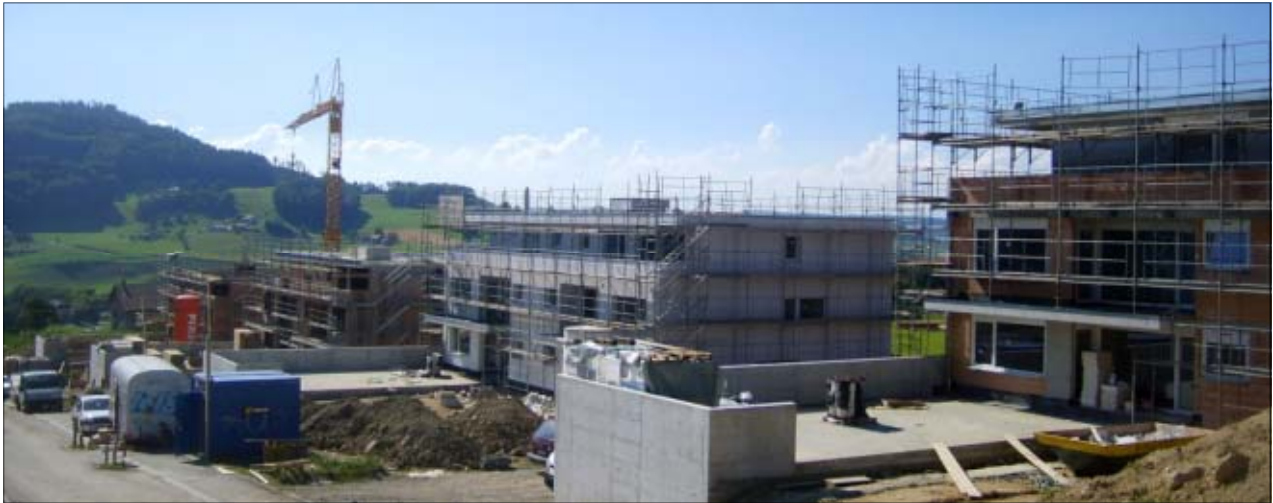
Divers degrés d'avancement de construction des immeubles
