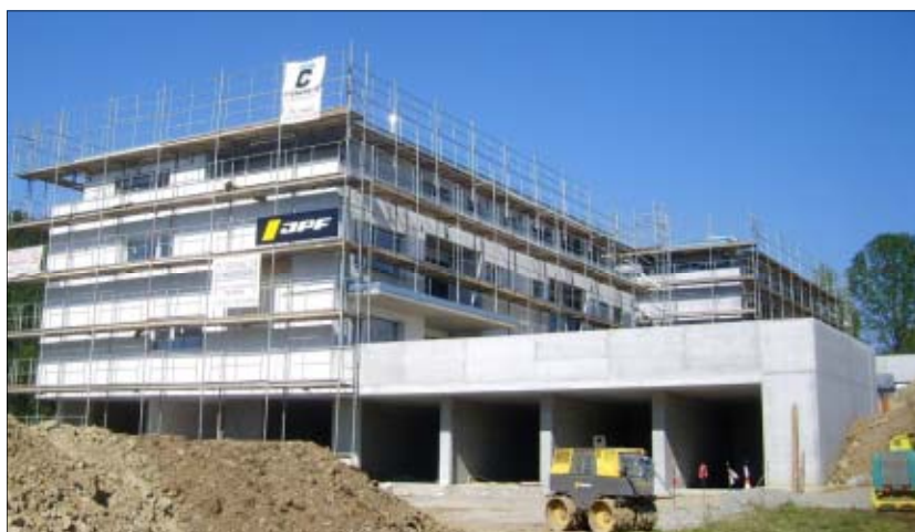
Travaux de revêtement de façade
