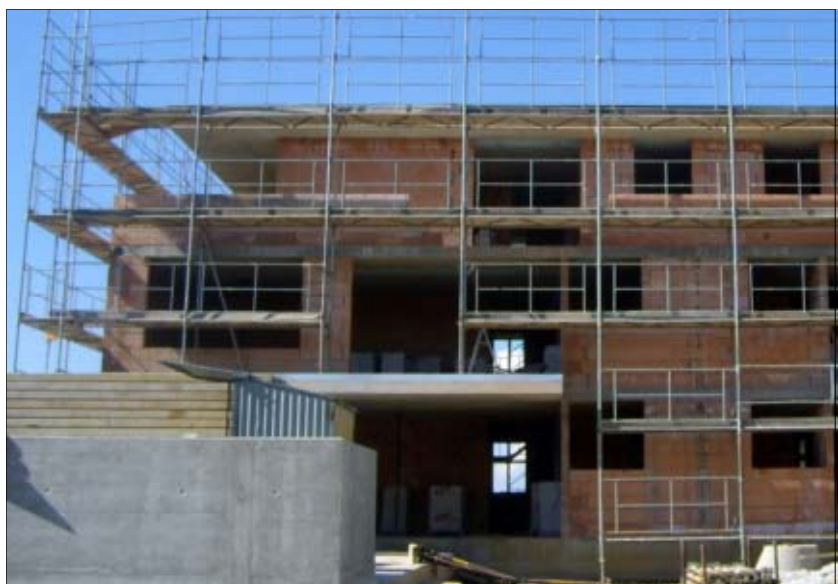
Structure du bâtiment en maçonnerie et béton armé
