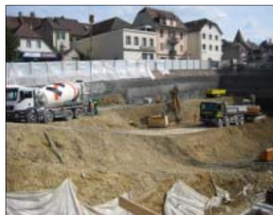
Terrassement et réalisation de parois clouées pour le soutènement des talus
