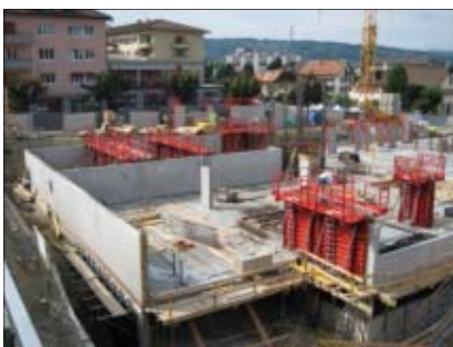
Coffrage et bétonnage des murs du parking
