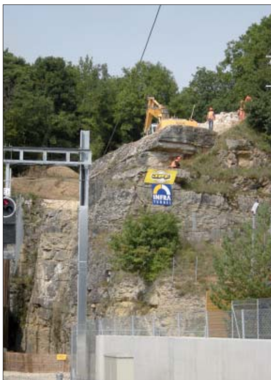
Perchée au sommet de la falaise, une machine de 40 tonnes a fait tomber environ 8000 m 3 de calcaire dur, avec tout ce que cela sous-entend sur le plan de la sécurité d'exploitation.
