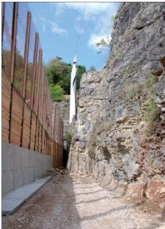
Dans la zone de la gare et du nouveau portail sud, il a fallu taper au marteau hydraulique dans une falaise surplombant le plan de roulement d'une vingtaine de mètres.
