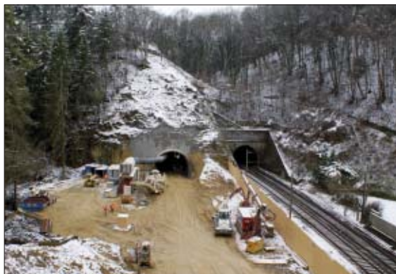
Vue plongeante sur les portails nord des tunnels sud depuis le tronçon à ciel ouvert d'Enteroches.
