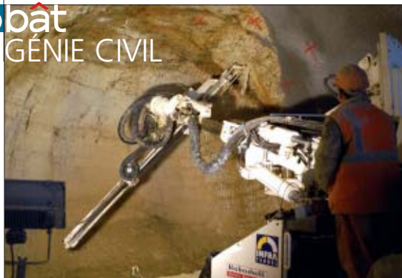
Forages pour mise place des ancrages dans le tunnel sud.
