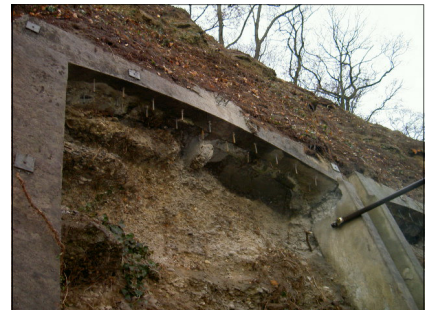
Contrefort existants avant réfection
