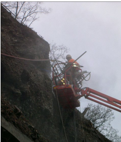
Projection du béton depuis la nacelle
