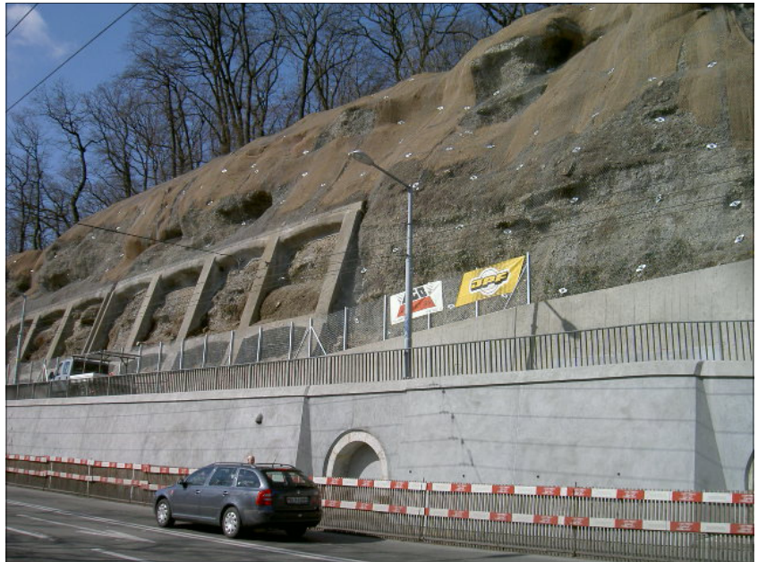
Travaux d'assainissement de la falaise et des murs existants terminés
