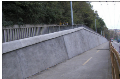
Paroi de protection provisoire fixée contre les contreforts existants
