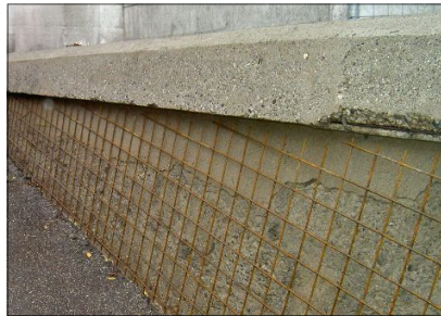
Treillis d'armature pour nouveau béton
