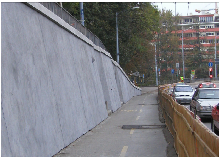
Nouvelle peau de béton sur mur existant
