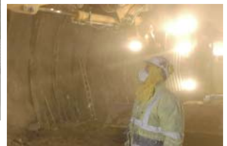
Conditions au front du tunnel
